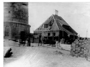
während des Baus ...
